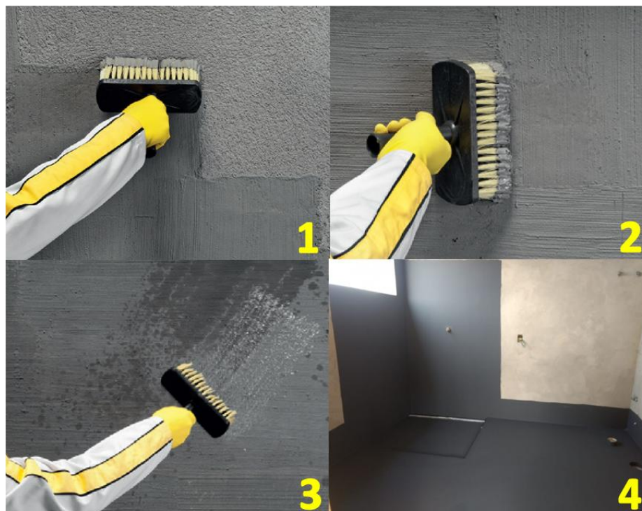
Figura 01 - Impermeabilização da área do banheiro.
